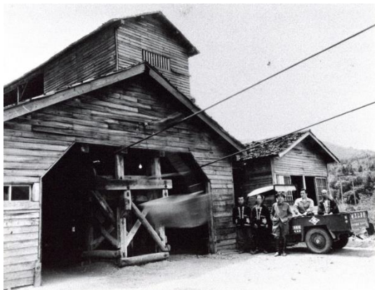
田瀬ダム建設索道ステーション(昭和25年頃)
