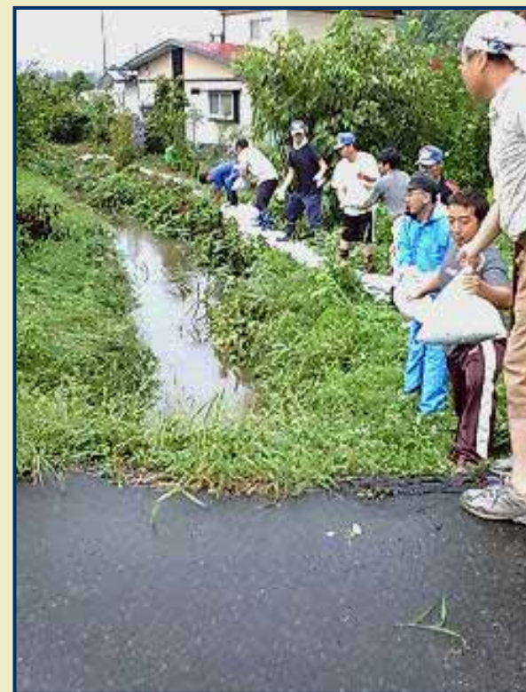
< 増水した排水路の土のう積み >
