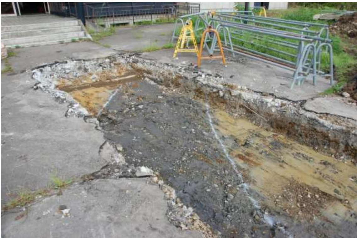
写真6 中央部（別館南側・本館西側） トレンチ⑦ 溝跡（南西から撮影）
