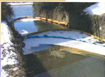
油の回収作業の様子
