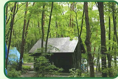
管理棟兼トイレ
