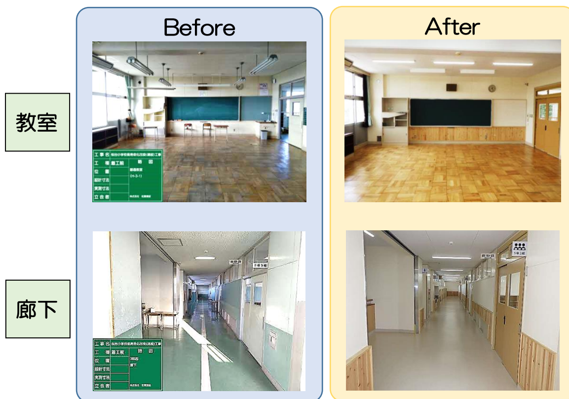
【図②】桜台小学校の長寿命化改良工事（令和4年度から令和6年度まで）前後の様子
