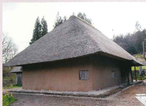
▲伊藤家の土壁 窓など開口部が少なく、柱が外側に現れない土壁は、この地域でも特に古い建築のたたずまいを良く伝えています。
