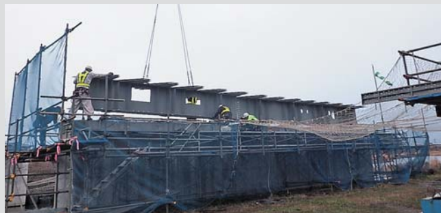
▲橋桁部材組み立ての様子
