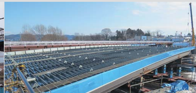
▲豊沢橋の工事現場
