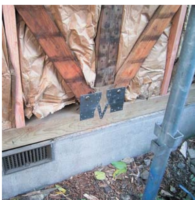
筋交いを施し、耐震補強を行った例
