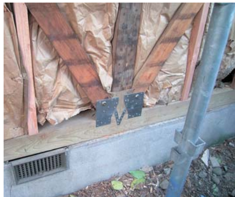
筋交いを施し、耐震補強を行った例
