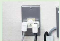
④分配器にテレビケーブルとコネクタを付けた同軸ケーブルを取り付ける
