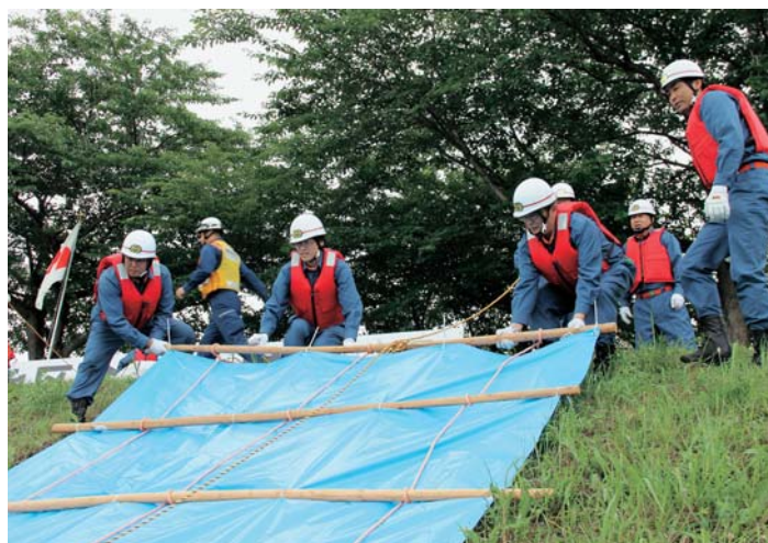
シート張り工法は、水の勢いで堤防がえぐられることを防ぐため、シートで斜面を保護する工法です
