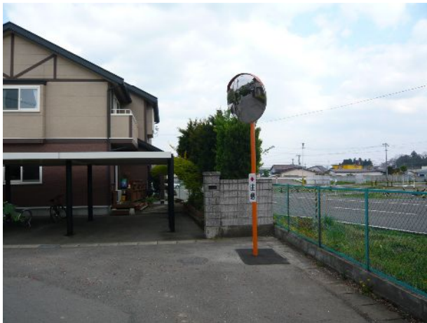
カーブミラー設置
