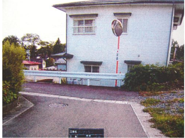
カーブミラー設置
