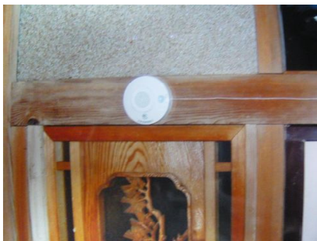
高齢世帯火災警報器設置
