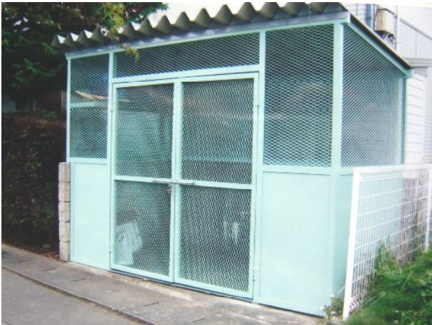
ごみ集積所改修
