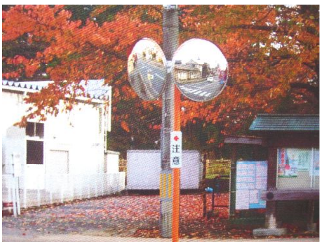
カーブミラー設置
