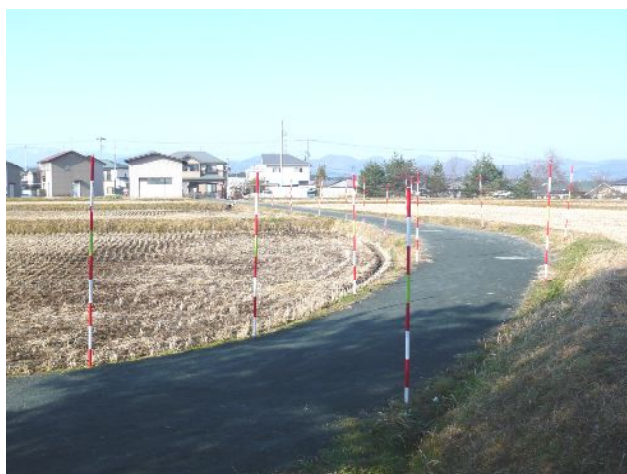
ユニポール設置
