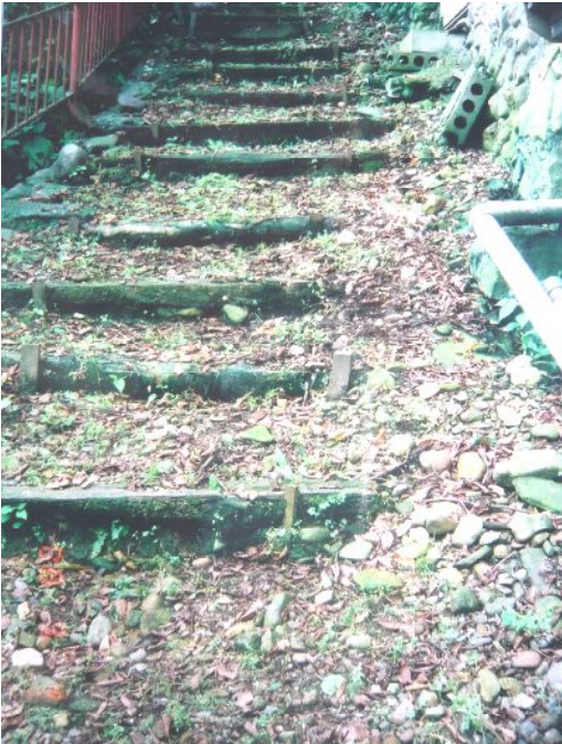
公民館入り口通路改修工事（改修前）
