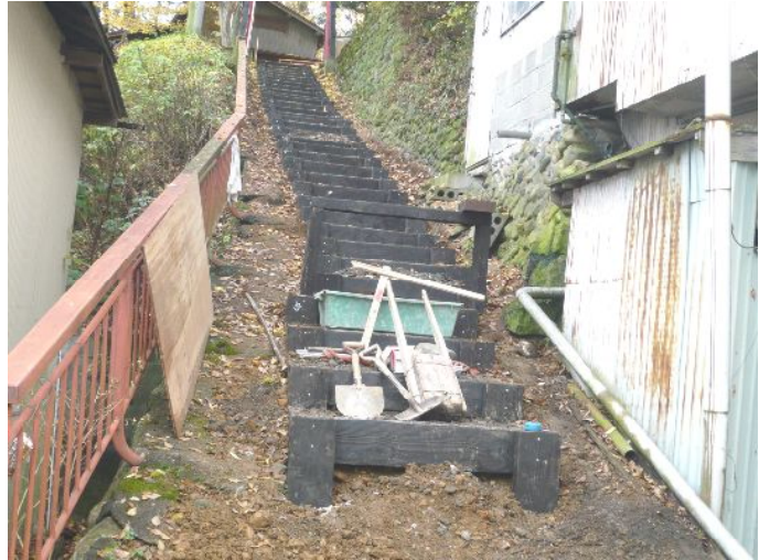
公民館入り口通路改修工事（改修中）
