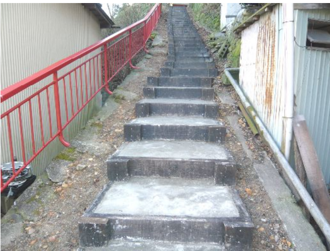
公民館入り口通路改修工事（完成）
