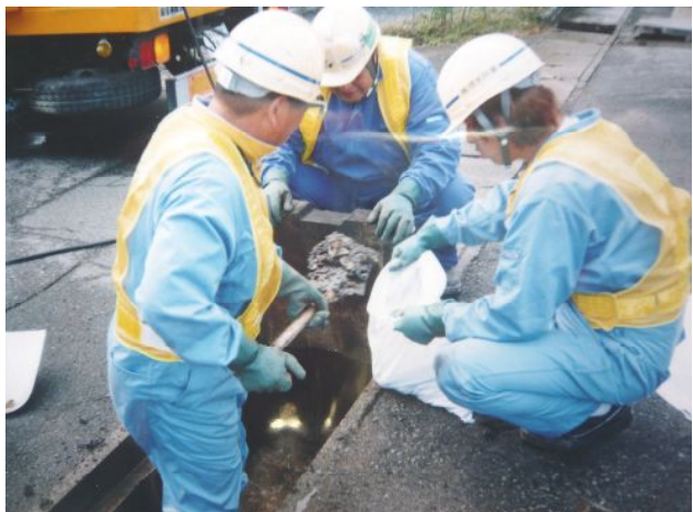
道路側溝泥上げ
