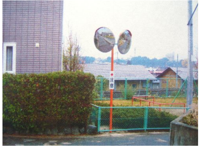
カーブミラー設置
