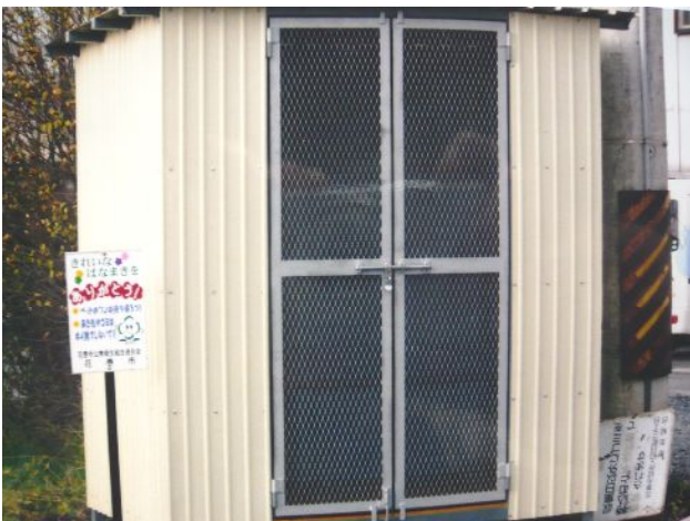
ごみ集積所改修
