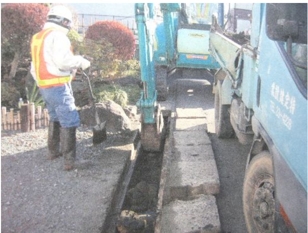
側溝汚泥除去
