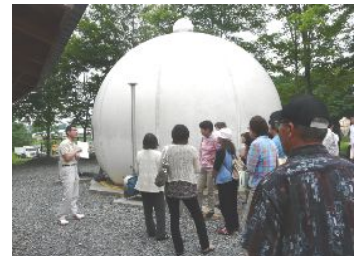
バイオガスプラント
