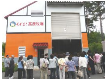
木質バイオマスプラント
