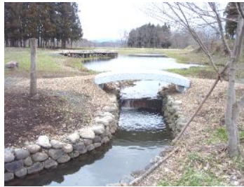
復旧工事でたいこ橋完成 (H20. 4. 1撮影)
