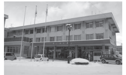
築47年の市役所本庁舎
