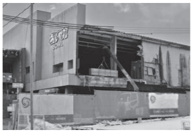
災害公営住宅建設により解体工事が行われている旧ボウリング場(仲町)
