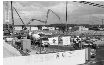
工事が進む総合花巻病院
