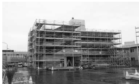
現在建設中の「シティコート花巻中央」
