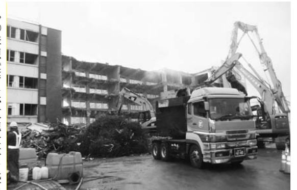
総合花巻病院が移転先と想定している県立花巻厚生病院跡地
