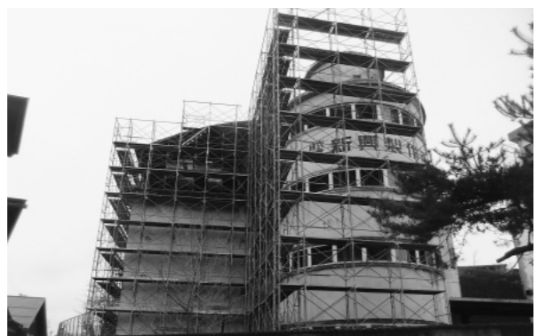
建物解体が進む旧新興製作所
