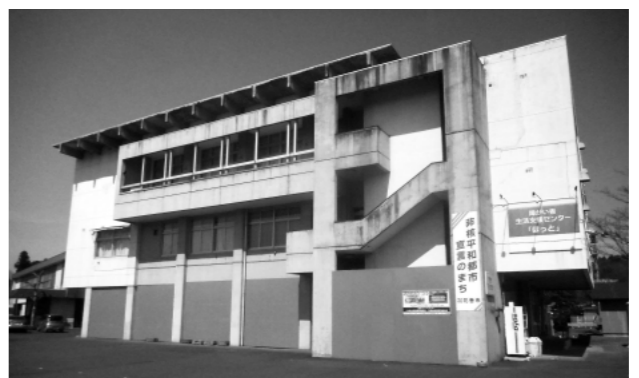
老朽化が進む公共施設(東和コミュニティセンター)
