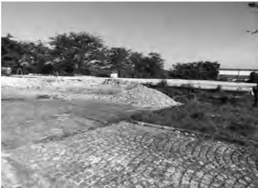
新興製作所跡地の上部平坦地
