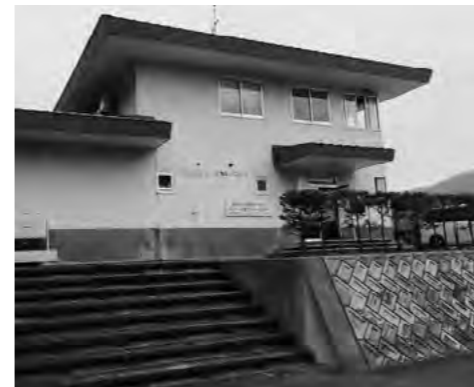
田瀬湖畔に建つ東和B & G海洋センター
