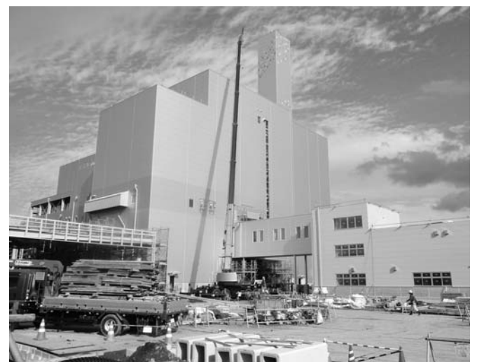
建設中の(仮称)岩手中部広域クリーンセンター(北上市)
