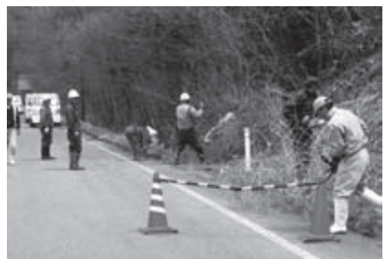
交付金を活用した泥上げと伐採事業
