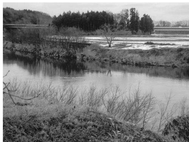
急がれる北上川河川の堤防整備(東雲(しのめ)橋付近・八重畑地内)
