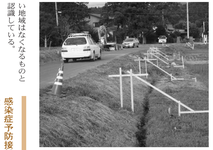
すれ違い困難な道路の改良整備
