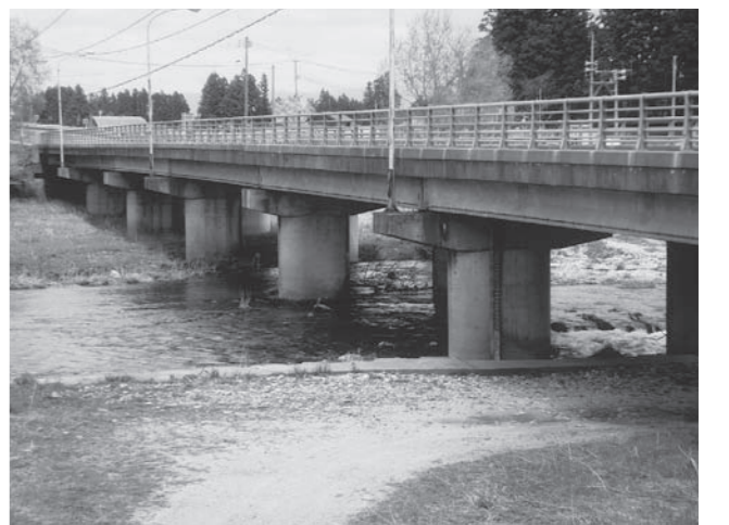
ボランティアに守られる市内の橋梁
