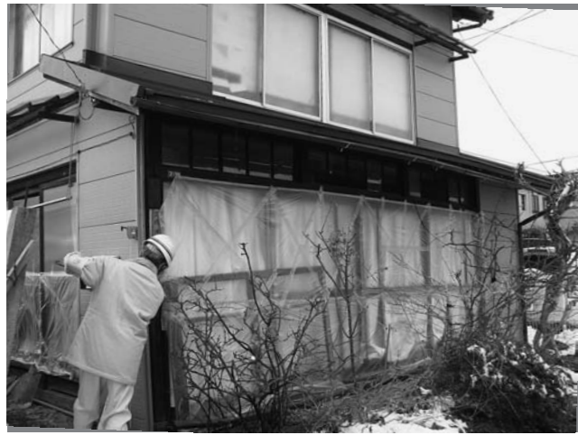
木造住宅耐震改修前の耐震診断
