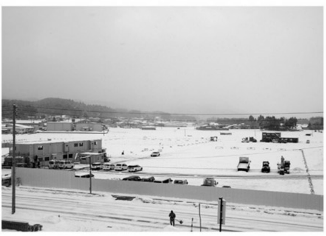
工事が進められている東和小学校
