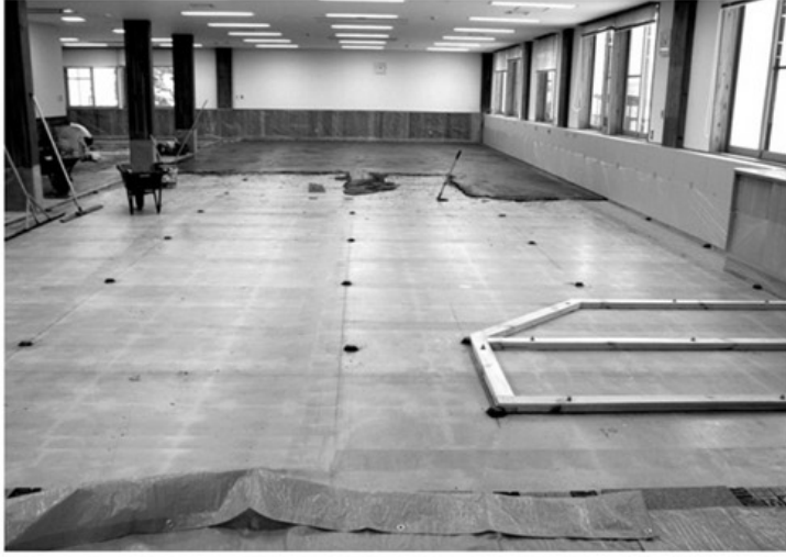
大迫総合支所では図書館の3月移転を目指して工事が進められています
