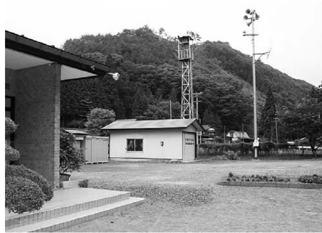
携帯電話の不感対策として、本年度中に移動通信用鉄塔が整備される大迫町外川目地内
