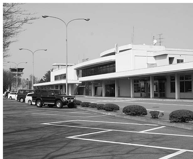
(仮称)空と文化の交流施設が整備される予定のいわて花巻空港旧ターミナルビル
