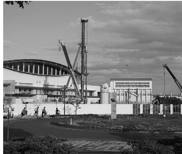
現在の総合体育館南側で進む増築工事
