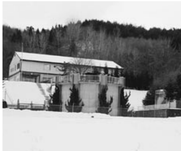
東和地区の簡易水道施設「竹中浄水場」では、1日当たり約1,000トンの浄水を供給しています
