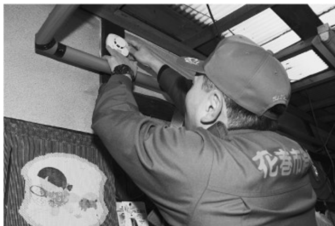
高齢者世帯を訪問し、火災警報器の取り付けを行う消防団員
