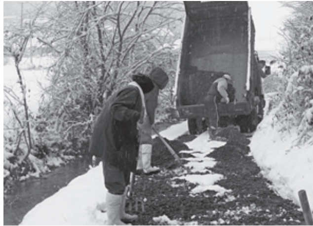
亀ヶ森コミュニティ会議で資材を購入し、地元の皆さんで作業を行った市道の碎石敷き(12/11)
