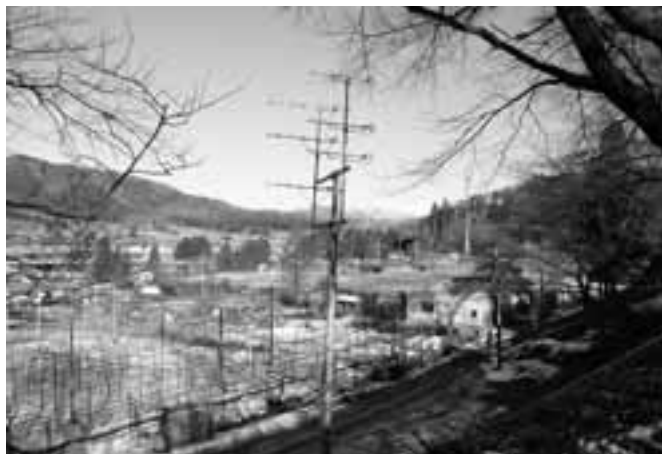
テレビ難視聴地域に設置されている共同受信施設
