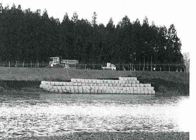
整備が進む北上川の築堤工事 (石鳥谷地区)
