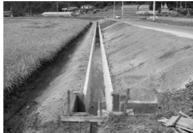
資材はコミュニティ協議会で購入し、地元の皆さんの手で完成させた側溝（八重畑地区）
