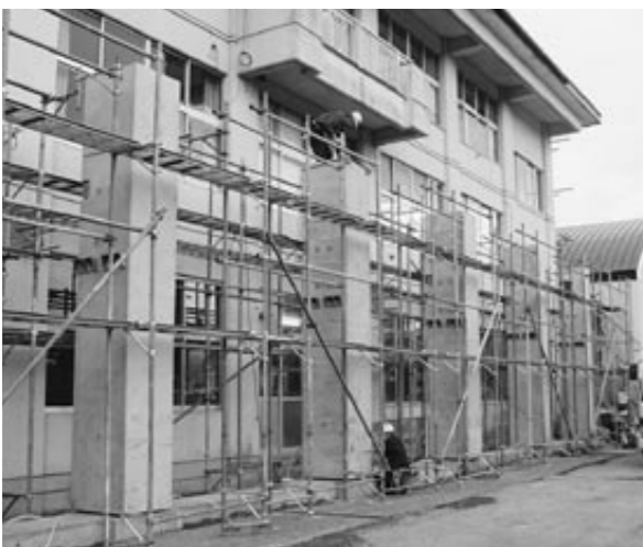
石鳥谷小学校で行われている耐震工事
