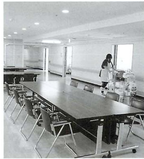
病院と併設した老人保健施設「イーハートープ介護リハビリセンター」では現在改装工事が進んでいます(写真は施設の食堂兼談話室)
