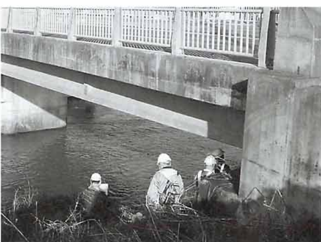
昨年度実施された橋梁点検
