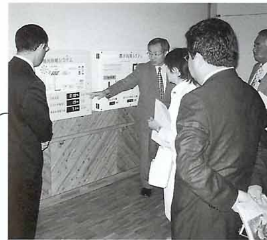
太陽光発電と雨水利用システムについて説明を受けました（帯広市立清川小学校）
